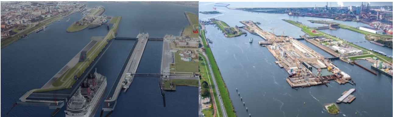
Visualisation and actual construction site new Amsterdam Sea Lock in IJmuiden (NL) © Rijkswaterstaat
