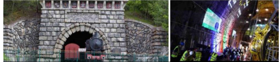
Brennero: il Tunnel di base a 150 anni dall'inaugurazione della ferrovia storica (1867)
